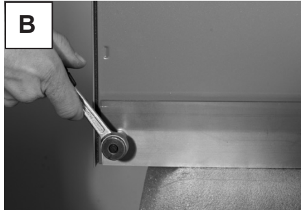
Avmontera nedre montagelisten
