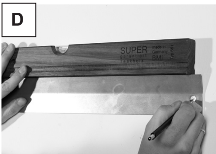
Rikta in den demonterade montagelisten på väggen och märk ut hålen på väggen
