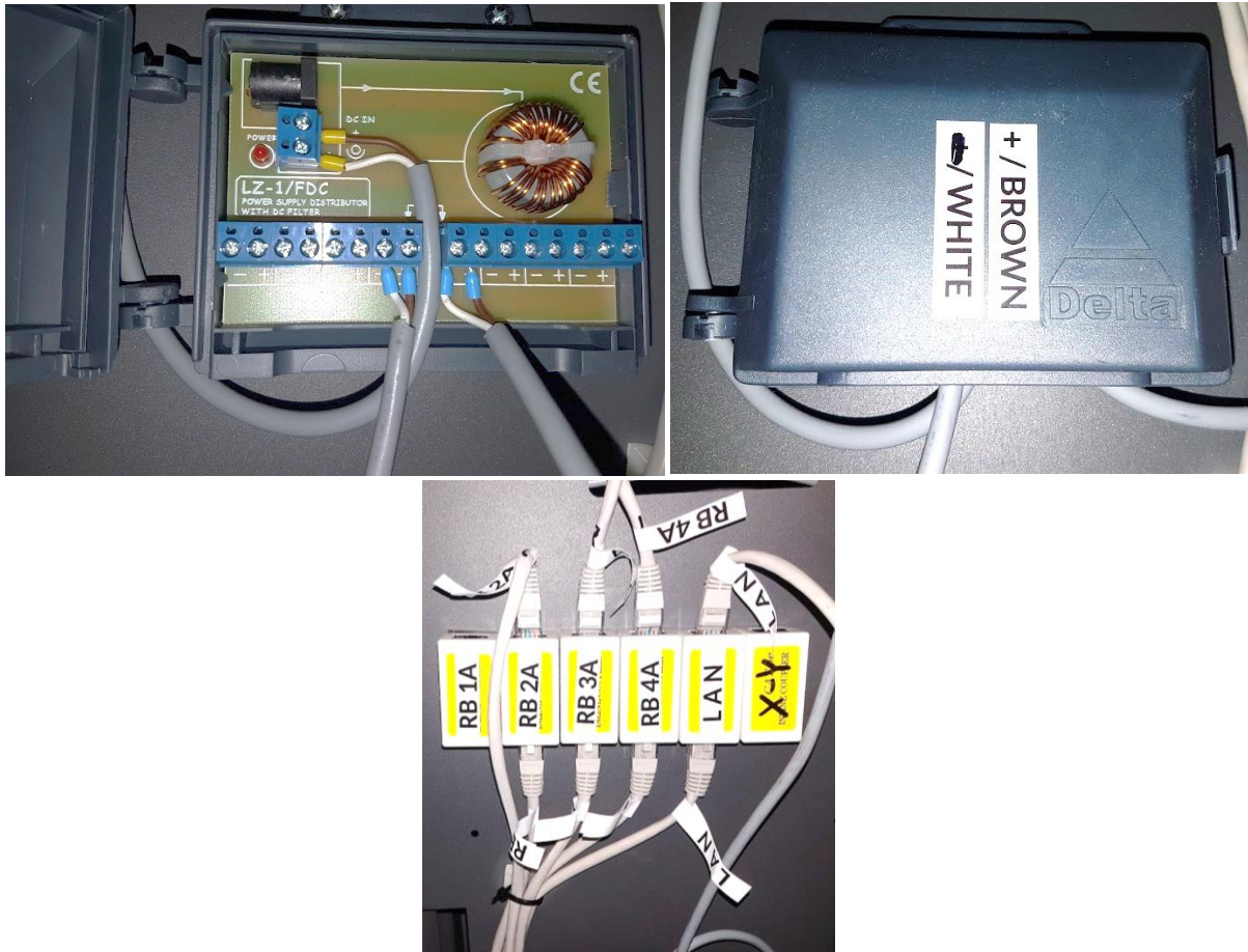
Foton från installation utav av ett boxsystem bestående av två sidomoduler
